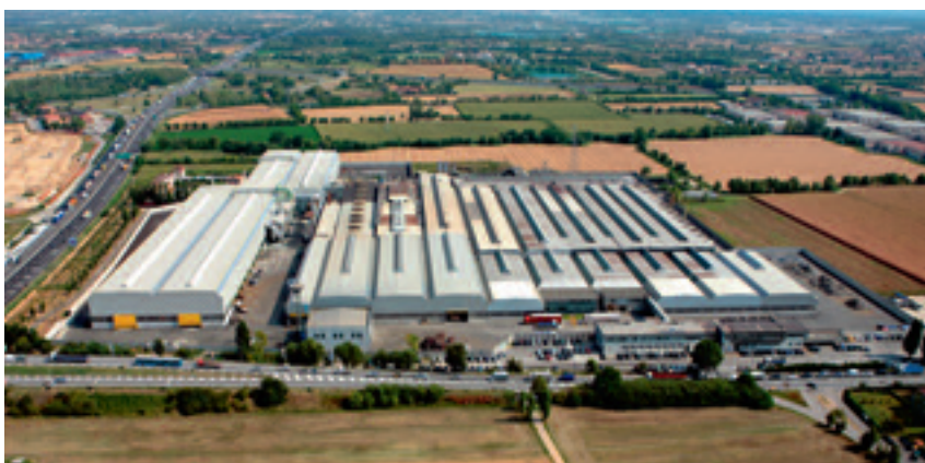
Impianto fotovoltaico da 5 MW su copertura industriale / Industrial facility photovoltaic plant 5 MW
